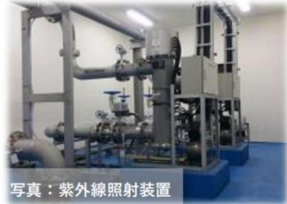
写真：紫外線照射装置
