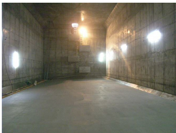
写真2-2 完成した合流改善対策施設（左：N o. 4滞水池、右：雨天時貯留沈澱池）
