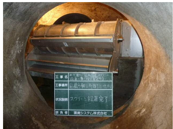
写真3-2 スクリーン設置後の様子 (吐き口 No. 18)
