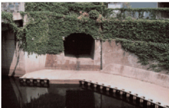
写真1-1 雨水吐き口からの未処理放流水の流出状況(他都市の例)
