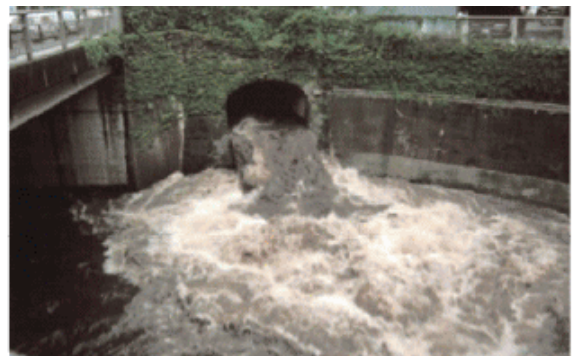
写真1-1 雨水吐き口からの未処理放流水の流出状況(他都市の例)
