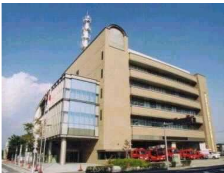
前橋市消防局庁舎（平成12年3月竣工）
