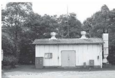
屋内貯蔵所の状況
