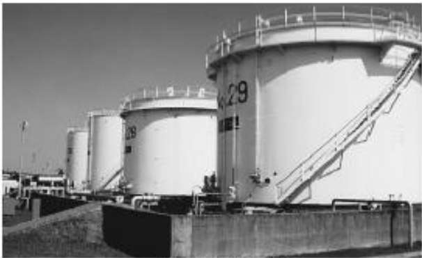
屋外タンクの状況
