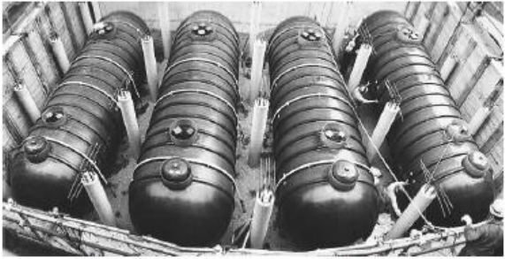
地下貯蔵タンク（FF二重殻タンク）埋設中の写真
