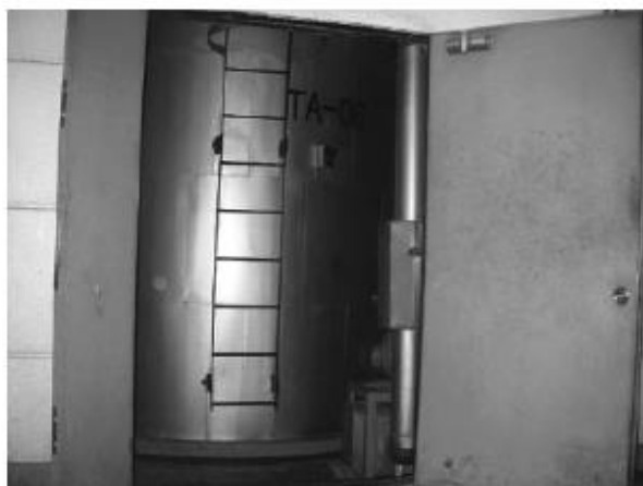
屋内タンク貯蔵所の状況
