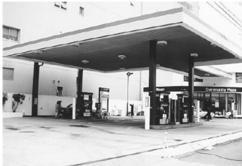
屋外給油取扱所
