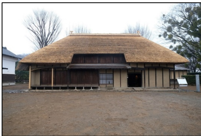
旧関根家住宅茅葺屋根改修工事
