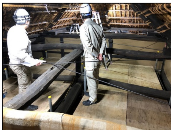
阿久沢家住宅耐震対策工事
