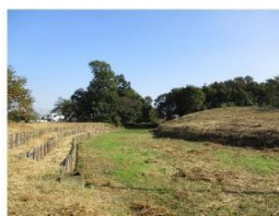
① 堀および掘削排土
