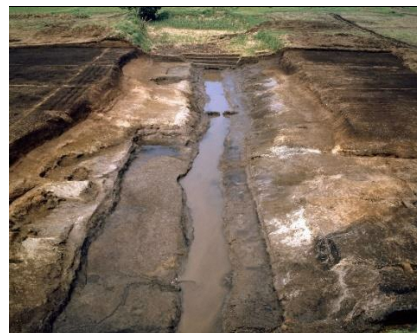
工事が中断した工区（二之宮地区上ノ坊）
