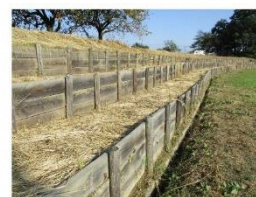
④ 土留構・U字溝
