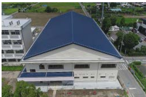
明桜中体育館新築工事
