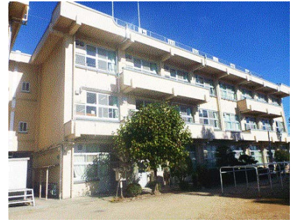
外壁落下防止工事
