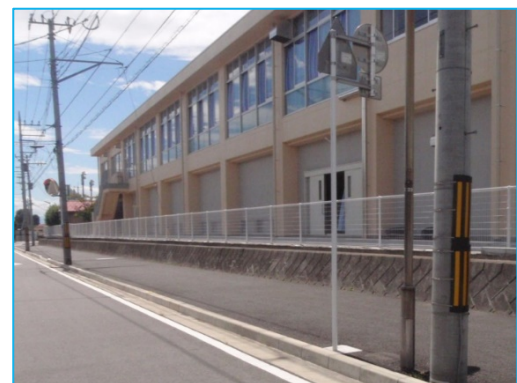
ブロック塀改修後
