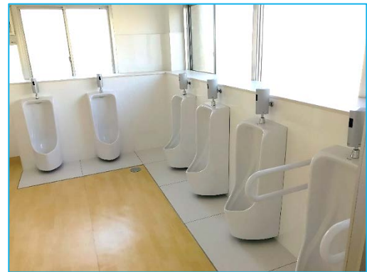
トイレ大規模改造工事
