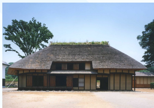
旧関根家住宅：市指定重要文化財 (茅葺屋根は定期的に差し茅・葺き替えが必要)
