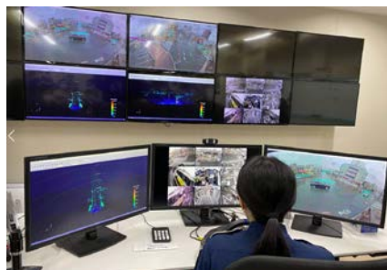
遠隔管制室 (次世代モビリティ社会実装研究センター内)
