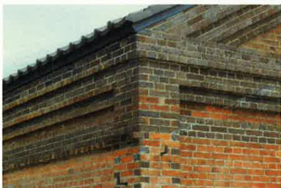
焼過煉瓦による軒蛇腹及び破風の様子
