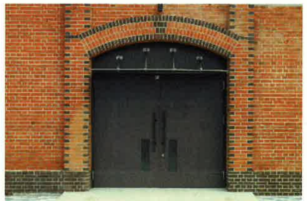
南側入口の粗迫持（弓形アーチ）と焼過煉瓦で要石を模した様子
