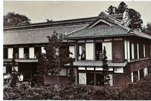
かつて敷地南側正面にあった、長屋門形の蚕室
