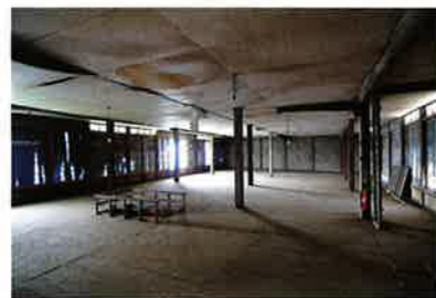
3階内部(北西より、天井は後補)
