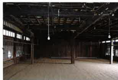
2階内部(北西より)
