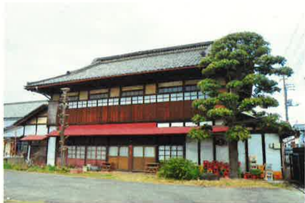
主屋を南側から見る
