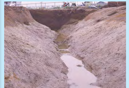
広域幹線用水路
