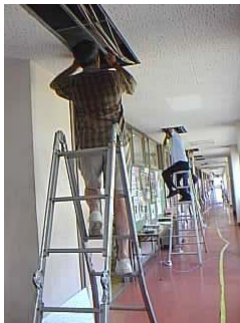
天井パネルを外しての配線工事
